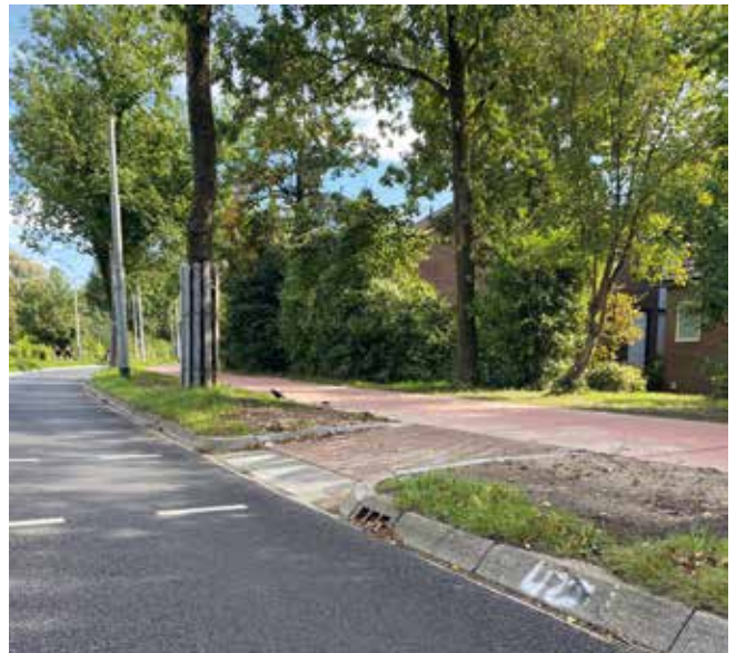
Een toe- en afrit van het fietspad
